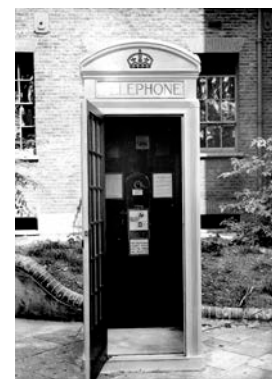
K2 Kiosk Interior 1925 (TCB 417/ E3365)
